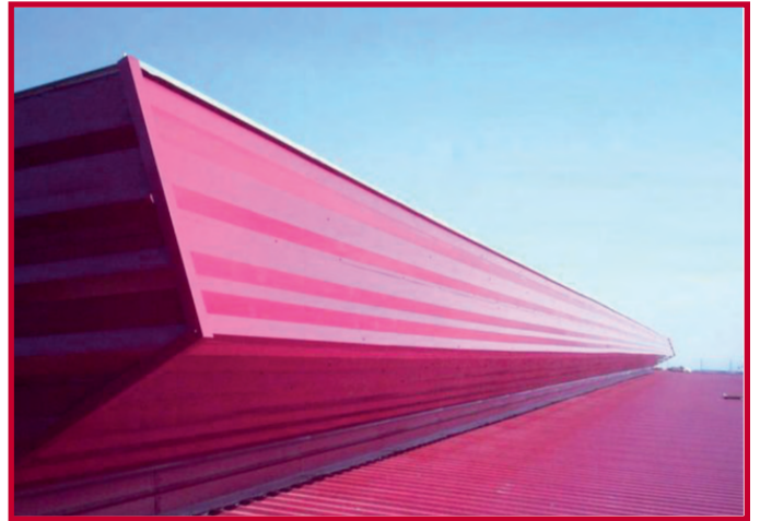
Ventiladores en Acería de Acerlormittal
