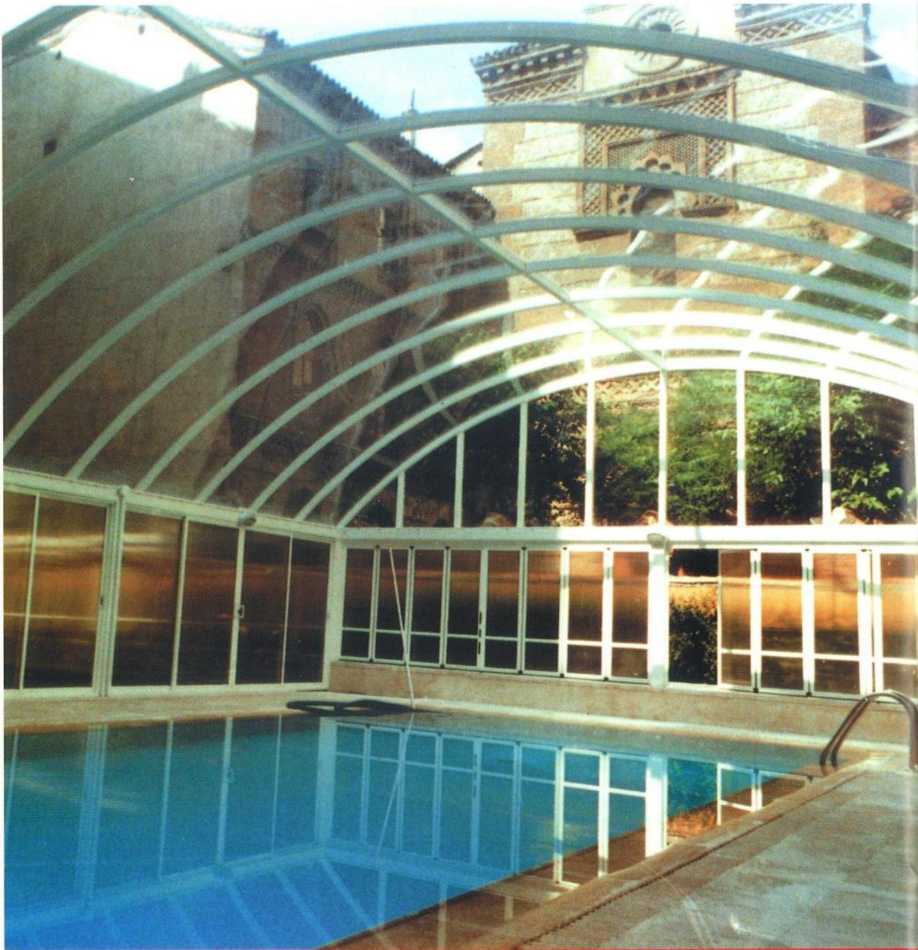
La alta tecnología SITRAPLAST, en lucernarios abovedados, está basada en la libre dilatación del material de cubrición (metracrilato o policarbonato) sobre una perfilería especial de aluminio, que ejerce una presión uniforme mediante el tensado en estribos de arcos, con tornillería oculta en acero inoxidable. De esta forma, y por propio diseño, se garantiza de por vida la estanqueidad y durabilidad del conjunto.
