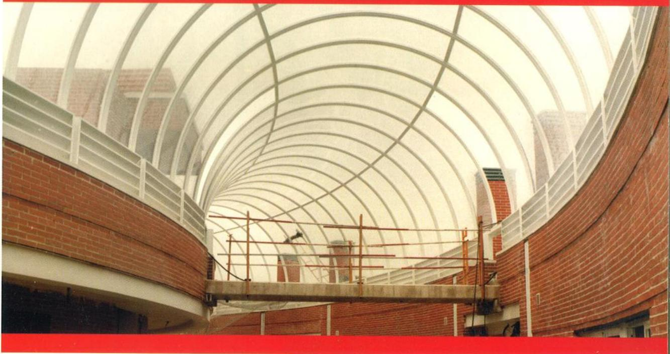
Nuestra perfilaría de aluminio lacado o anodizado, junto con la nobleza del metacrilato o policarbonato, nos da, en conjunto, bellas y útiles soluciones arquitectónicas, con su tornillería oculta y la garantía de estanqueidad que ofrece el propio diseño de su perfilaría flotante.
